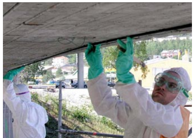
Jernbanebro ved Örnsköldsvik, Sverige, forstærkes med kulfiber, og belastes derefter til brud. EU-forskningsprojektet „Sustainable Bridges“.
